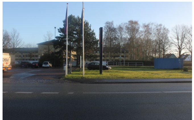
Figur 10: Slotspavillonens trinbræt - manglende parkering
