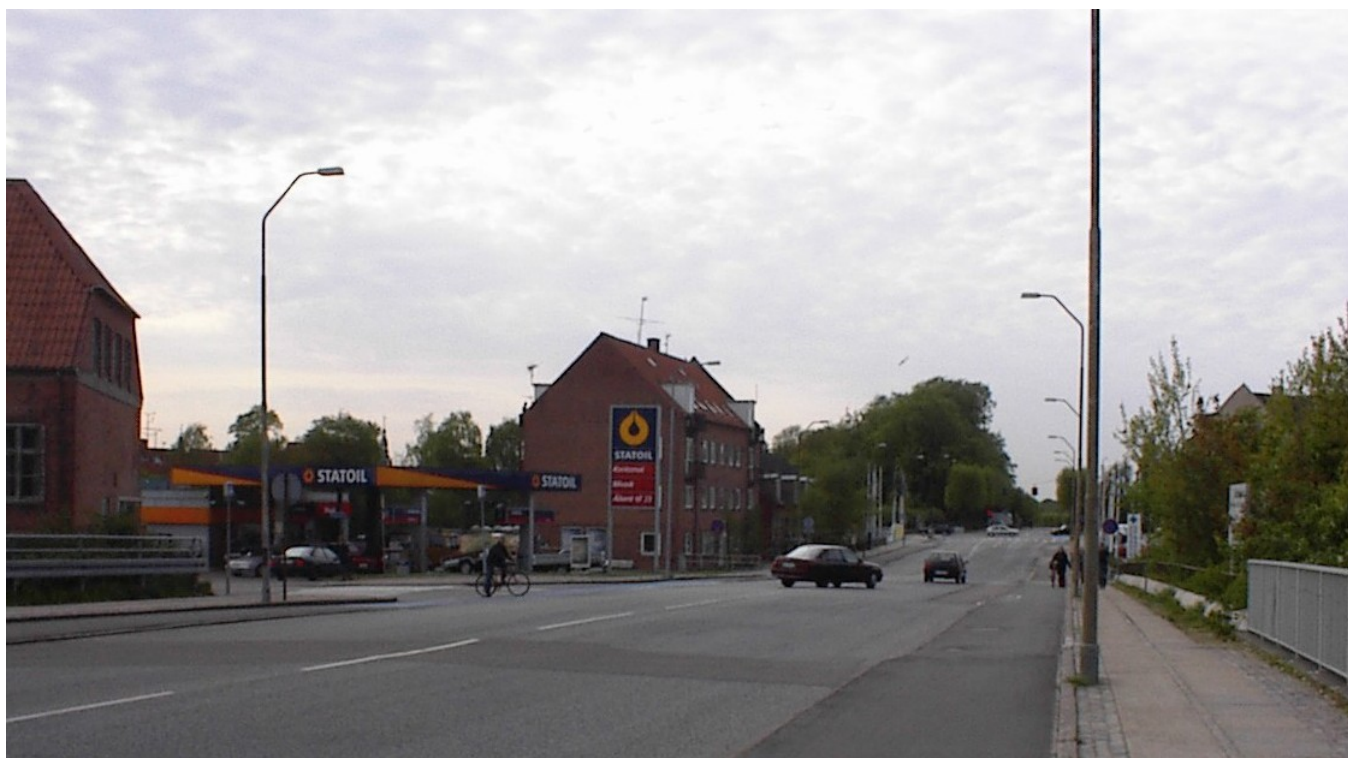
Figur 20: Langesvej/Københavnsvej - usikker stikrydsning
