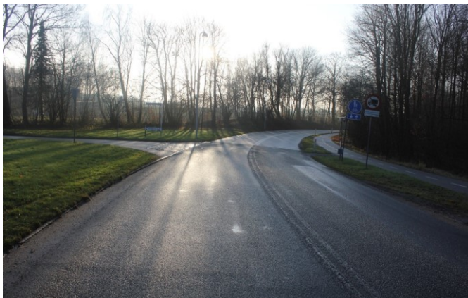
Figur 9: Selskovvej/Frydenborgvej - manglende stikrydsning
