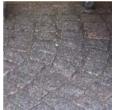
Chaussésten er en robust granitbelægning, som ofte ses i byrum.
