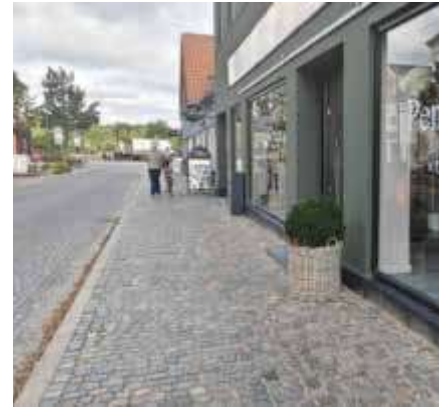
Øst: I udstillings- og inventarzone er der anvendt chaussésten med kløvet overflade mens der i gangzonen er anvendt sten med savet og jetbrændt overflade.
