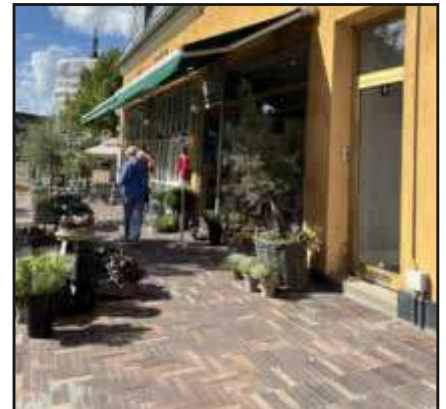
Færdselszone og arealer foran indgange er markeret med belægning lagt i dobbelt sildebensforbandt. Disse arealer skal friholdes.
