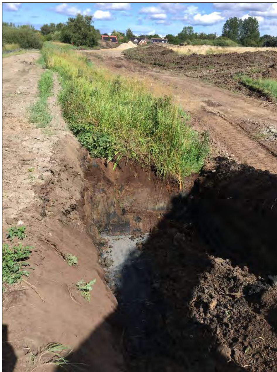
Foto 1: Foto af starten af Stenfeltslillegrøften i station 0. Fotoet er taget i nedstrøms retning og viser den søgegravning, der blev foretaget for at lokalisere eventuelle rørtiløb i starten af vandløbet. Foto er taget den 24. august 2020.
