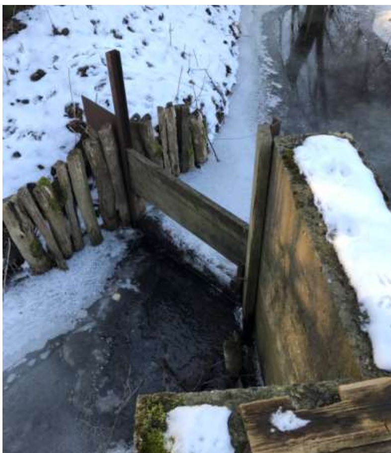
Figur 2-4: Fordelingsbygværk ved Stenholt Mølle. Åbningen på billedet leder vand til omløbet, mens vand til møllekanalen løber på højre side af betonbygværket på billedet
