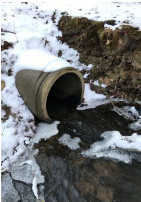
Figur 2-5 Rørføring under skovvejen nedstrøms Følstrup Dam.
