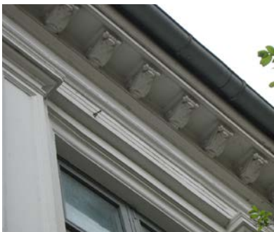
Detalje af profileret gesims på facaden mod gågaden, Slotsgade 25
