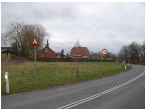
En del af lokalplanområdet set fra Meløsevej (set fra nord). Til venstre ses den eksisterende gulstensbygning, som nedrives ved realiseringen af lokalplanen.
