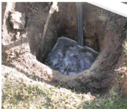
5. Hullet holdes vandfyldt med 0,20 m vand i ca. 30 min. I våde perioder (med meget regn) kan dette nedsættes til 15 min.
