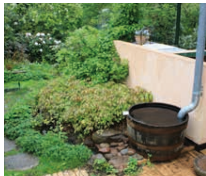
Opsamling af regnvand til havevanding
