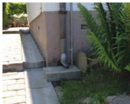
Betonrende til at transportere vandet
