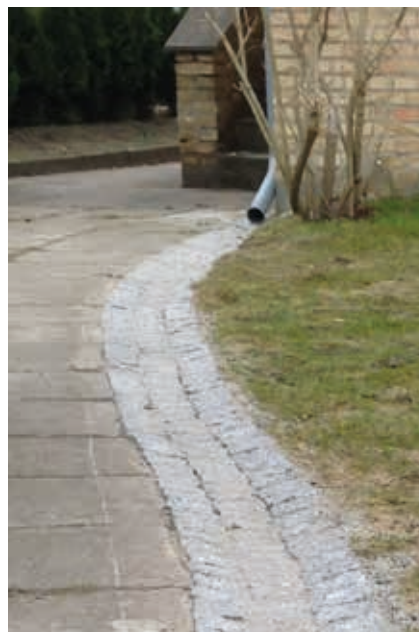
Rende sat mellem græs og betonflise
