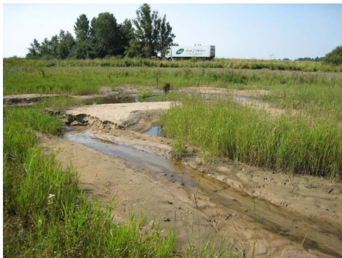
Skader på vandløb efter ekstremregn i 2007
