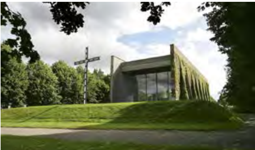
Skansekapellet, Hillerød (1961) Bornebusch (1925-2011), Brüel (1927-95) og Selchau (1923-97) og Sven Hansen (1910-89) Bygningen markerer landskabet ved at placere sig på toppen
