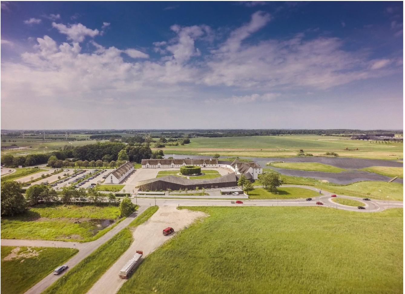
Området set mod vest med Roskildevej og rundkørslen midt i billedet og derefter naboarealet ved Novos kursusejendom Favrholm Campus.
