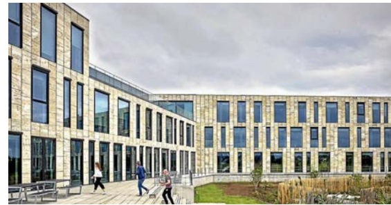
Foss, Hillerød Rambøll Arkitektur & Byudvikling Forskydning i facader, variation i etageantal og vinduesrytme, facademateriale i varm farve med farvespil.
