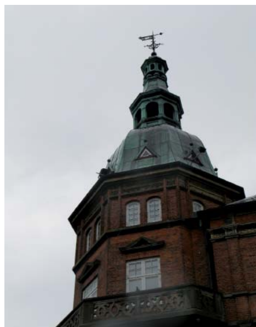
Hjørnetårnet på "Bankbygningen"
